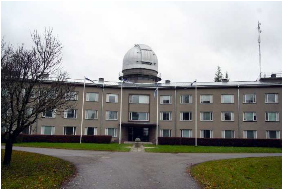
Tartu Observatooriumi peahoone enne põhjalikku remonti 2012. aastal.
